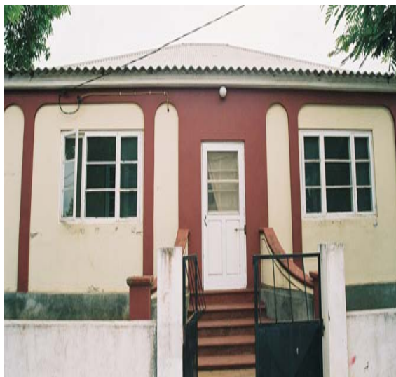
Futuras instalações da Biblioteca
